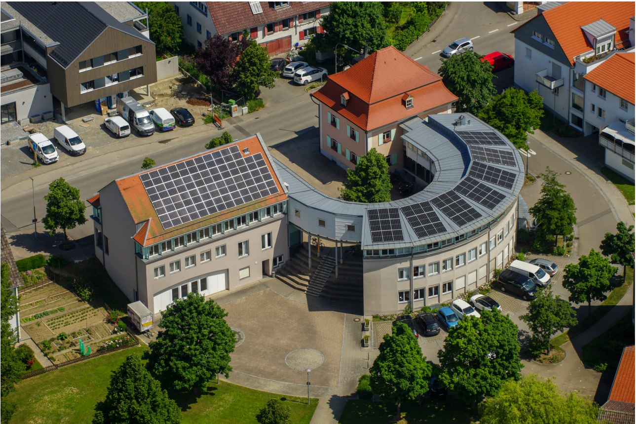
Die PV-Anlagen auf dem Rathaus aus der Luft—Aufnahme von Gerhard Plessing
