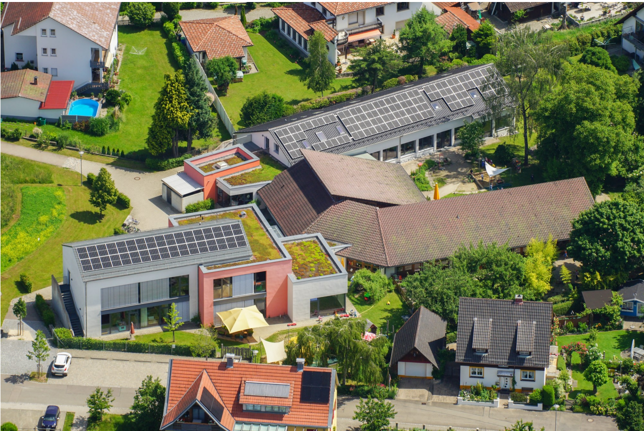
Die PV-Anlage auf dem Dach des Kinderhauses St. Nikolaus—Luftaufnahme von Gerhard Plessing
