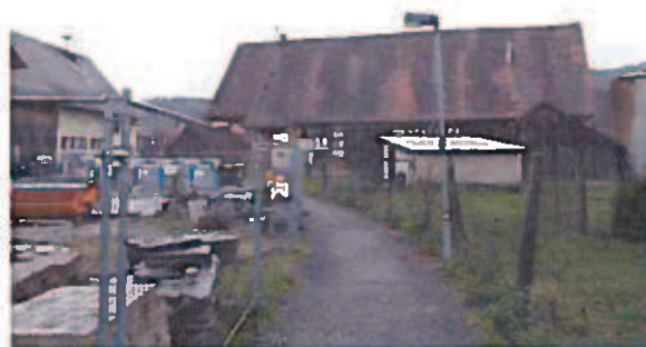
Blick von Norden
